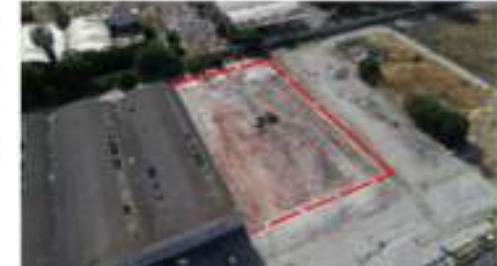
CAPANNONE N°25 1- PRIMA DELLA DEMOLIZIONE; 2- DOPO LA DEMOLIZIONE
